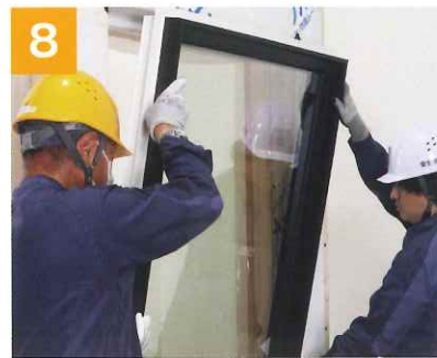
8 窓を取付け、 窓まわりに防水テープを貼る 施工説明書を参照して取付け、四方の防水処 理を行ってください。
