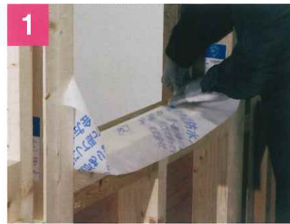
1 開口部下側に 先張り防水シートを張る
