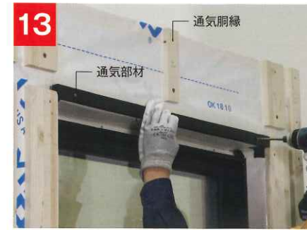
13 通気胴縁を取付ける 胴縁と併せて開口部上部に通気部材も取付けます。
