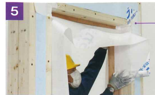
5 上・左右に透湿防水シートを張る 上隅部に捨て張りしてから、開口部の上・たて枠側面にシートを張ります(2の防湿気密フィルムの上に一部重ねながら)。
