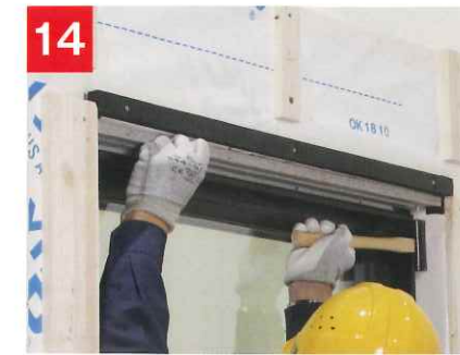
14 上部巻込み部の サイディングを取付ける 開口部上部の通気部材内側部分に外壁を設置します。
