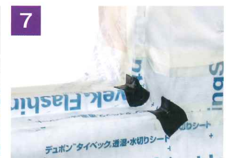
7 四隅に入隅用防水テープを貼る プチルテープなど隅部になじむ伸縮性のあるものを使うことでピンホールを密封します。
