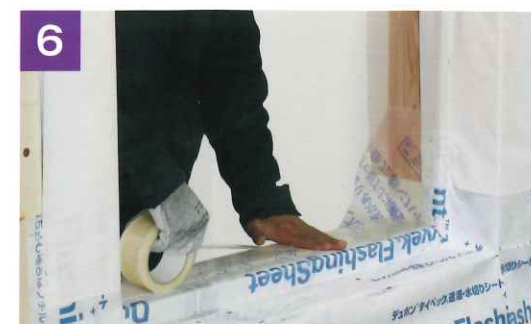
6 ジョイント部を気密防水テープで押さえる 1・2の室内側のシート・フィルムと4・5の室外側のシートの重なるジョイント部(四方)を気密防水テープで押さえます。併せて、四隅の捨て張りシートとのジョイント部も押さえます。
