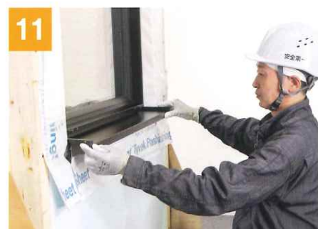
11 水切を取付ける 窓枠に対して左右のチリが均等になるよう位置を 決め、ねじ固定します。
