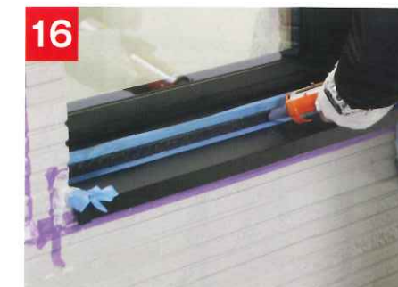
16 シーリングする 窓枠まわりのほか、窓下枠と水切の間、外壁と水切 の間をシーリングします。
