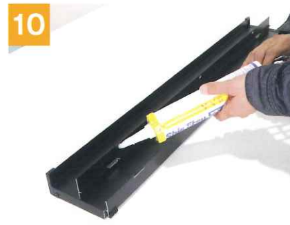
10 水切のねじ止め穴に防水処理する 水切のフィン裏側から、ねじ固定用の各穴を覆う ようにシーリングします。プチル防水テープを貼 付ける方法でも可能です。
