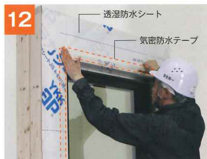
12 壁面に透湿防水シートを施工する 開口部の上・左右のシート端部は気密防水テープで 押さえます。
