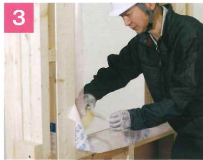
3 1と2のジョイント部を 気密防水テープで押さえる
