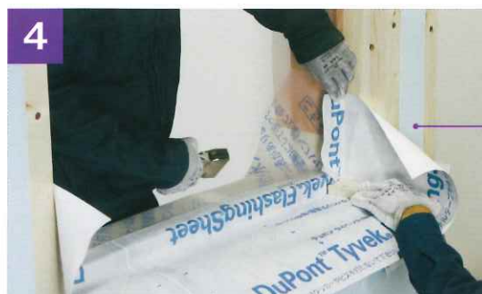
4 下側に先張り防水シートを張る
